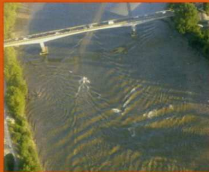
Figure 15 : photographie aérienne P1050769 prise à 17h43'47" (TU) montrant le mascaret qui passe sous le pont au Pk 37,9, avec apparition de vagues de formes concaves.
